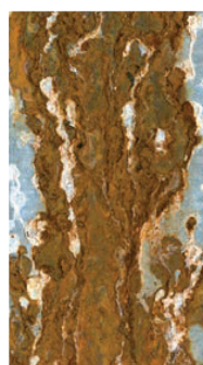
Galvanisation à chaud 20 µm après 6 semaines
