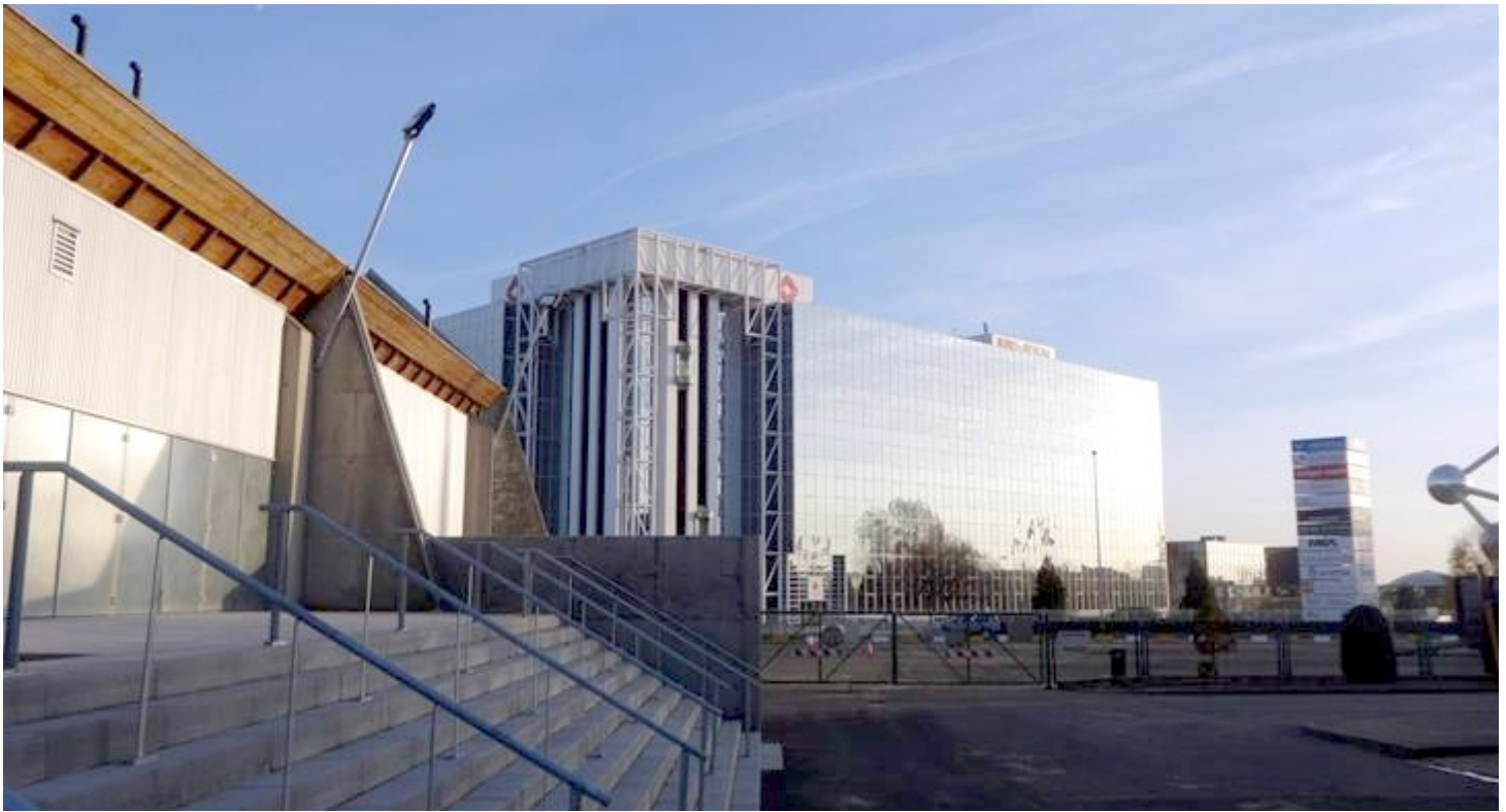
Les sorties de secours du Palais 12 à Brussel doivent garantir un passage sûr dans les situations de panique
